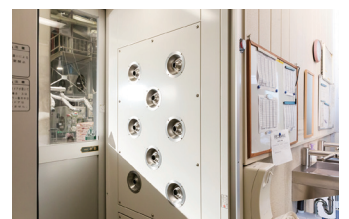
● エアシャワー 精米工場内に入る際に、埃などを取り払います。
